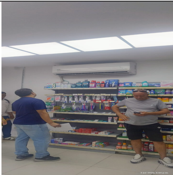
Verificación de aire acondicionado área de usuarios
